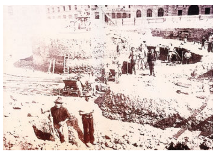
È il 1942, sotto piazza Dante si scava il rifugio antiaereo, futuro Diurno
